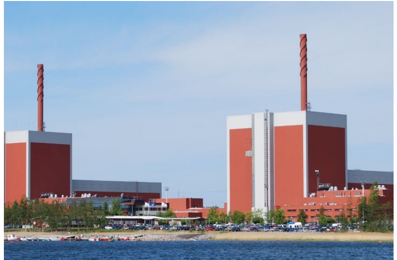
rawpixel/Wikimedia Commons Finland's Olkiluoto 3 nuclear power plant
