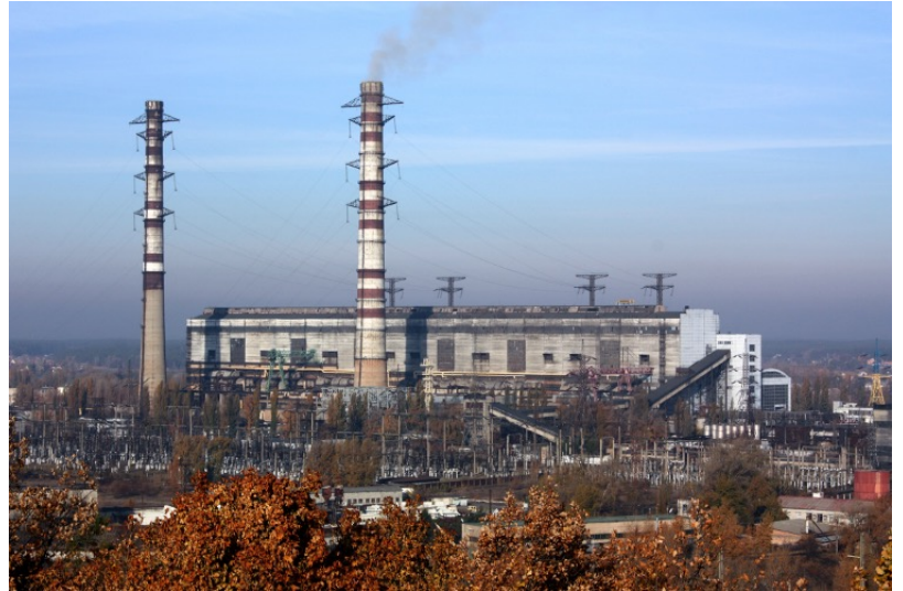
Dmitri Tovstonog/Wikimedia Commons Trypilska Thermal Power Plant
